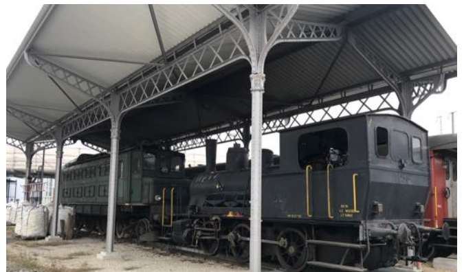
Perron von 1882 Bahnhof Bellinzona
